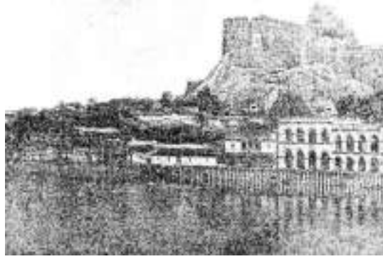
شكل ٢-٦: ترى جنابلي. منظر المدينة وقلعتها.
