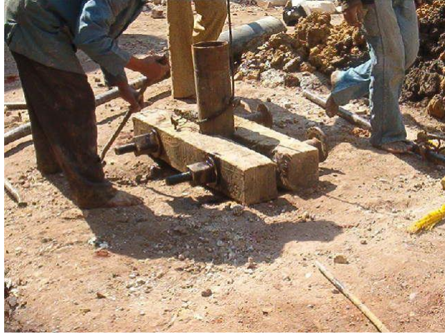
« الصورة التالية توضح مواسير قطرها 6 بوصة »
