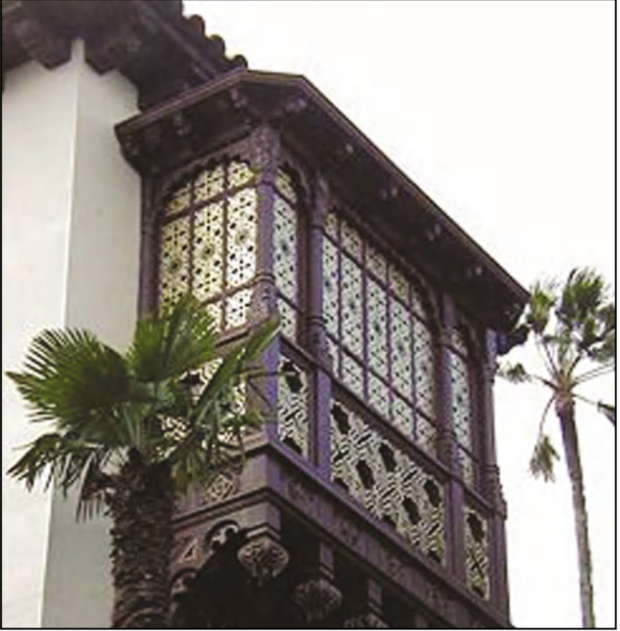
المشربيات تزين واجهة الدار وتساعد في التخفيف من درجة الحرارة وتسهم في ضبط دورة الهواء
