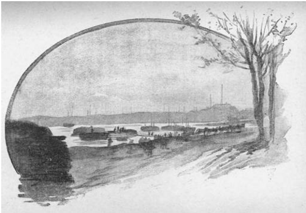
Les quais étaient envahis.
