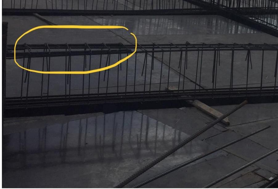
سادسا : ( بالنسبة للسقف الكمري ) يتم تعليق حديد الجسور الاساسي بأشواير اعمدة السقف بواسطة ( الاسلاك وخشب طفش ) وذلك لسهولة تركيب الحديد الاضافي و الكانات ولا تسمح بتنزيل الجسور الا بعد ان يتم التأكد تماما من استلام ( الحديد الاساسي ) و ( الحديد الاضافي ) و ( الكانات )
