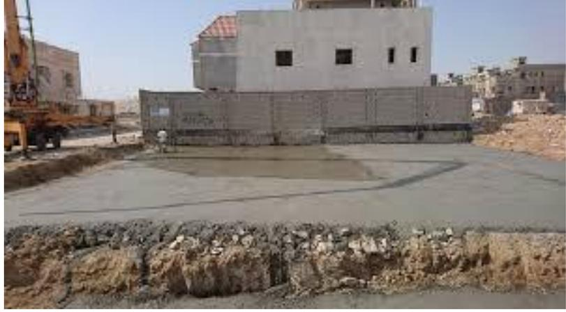
هي خرسانه عادية تبلغ سماكة خرسانه النظافة ٥-١٥ سم تحتوي القواعد و ليس لها اي وظيفة انشائية .
