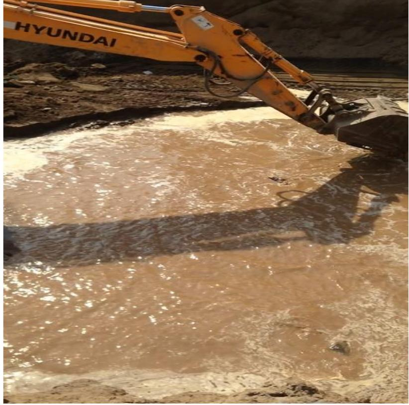
بعد ذلك ننتظر الى اليوم الثاني حتى يتم ترشيح المياه اسفل تربة التأسيس و من علامات صحة الطريقة هو ترشيح المياه وبقاء القليل من المياه بحفرة التأسيس
