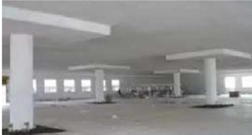
هذا طريقة نجارة سقوط تسليح drop panel
