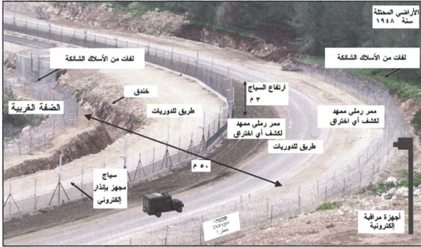
شكل (1): مقطع يوضح مكونات الجدار العازل
