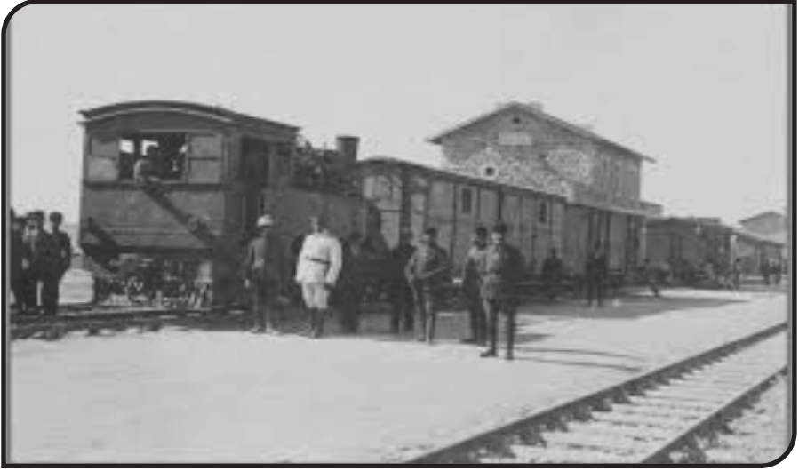
أثناء بناء سكة الحديد في المدينة
